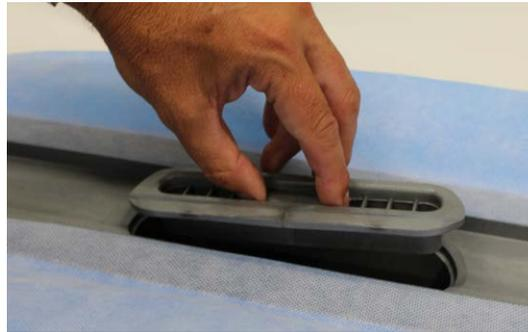
6. Colocar el cierre hidráulico (solamente en el caso de que la instalación no esté conectada a un bote sifónico central).
