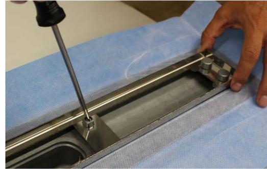
3. Nivelar la altura de la cuna de la canaleta, girando los tornillos de los pivotes de apoyo, hasta alcanzar el nivel del pavimento a utilizar.
