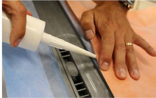
2. Encastrar la base de la canal dentro del propio mortero de pendientes (no son necesarias usar las patas que incluye el kit para fijarla). Realizar las pendientes de obra. Pegar las láminas con cemento cola C2 y finalizar la unión entre las mismas poniendo un cordón de masilla polímera al final del solape.
